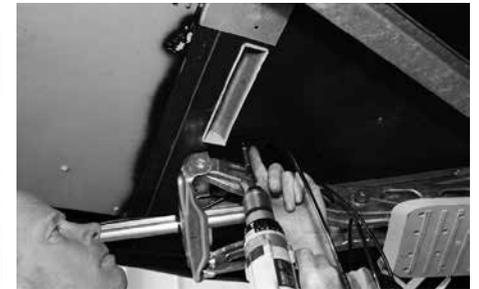
*Die Leitungen sind mit dem mitgelieferten Material am Boden zu befestigen.*
