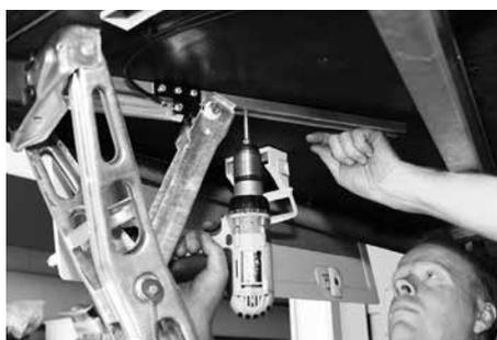
Perçage préalable des deux dernières vis de fixation.
